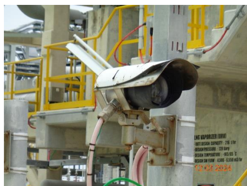
เครื่องตรวจจับก๊าซ (Gas detector) ที่ติดตั้งไว้ในพื้นที่โครงการ
