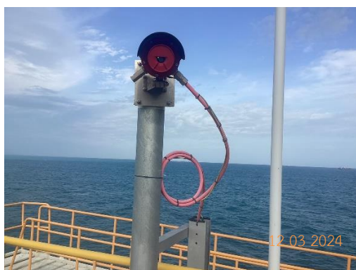
เครื่องตรวจจับก๊าซ (Gas detector) ที่ติดตั้งไว้บริเวณท่าเทียบเรือ
