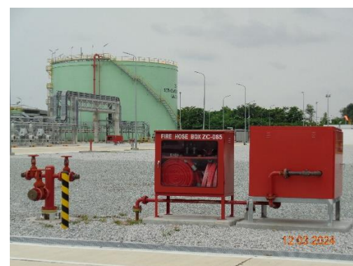
อุปกรณ์ดับเพลิงที่ติดตั้งไว้ในพื้นที่โครงการ
